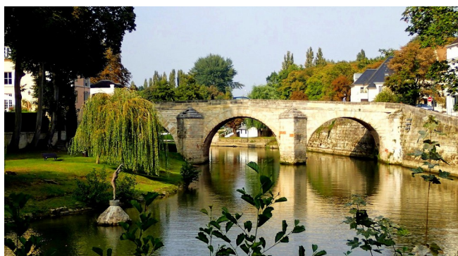
Le Pont du Cabouillet sur l'Oise
